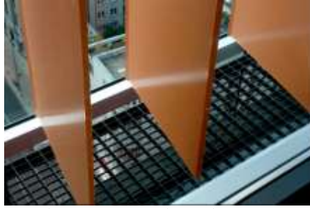
صورة رقم (6) التجايف بين طبقات الواجهة الغربية والتي تعمل كمناطق عزل حراري. (مرجع رقم " 9 "
